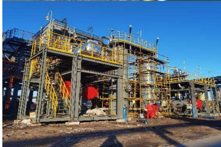
分子筛脱水橇模型与实物对比
